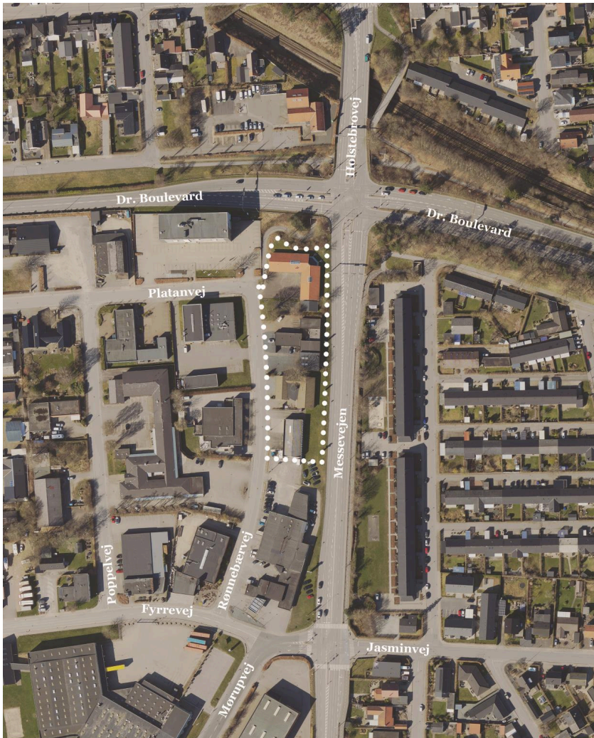
Luftfoto af lokalplanarealet og nærområdet. Lokalplanområdet markeret af hvid prikket linje.
