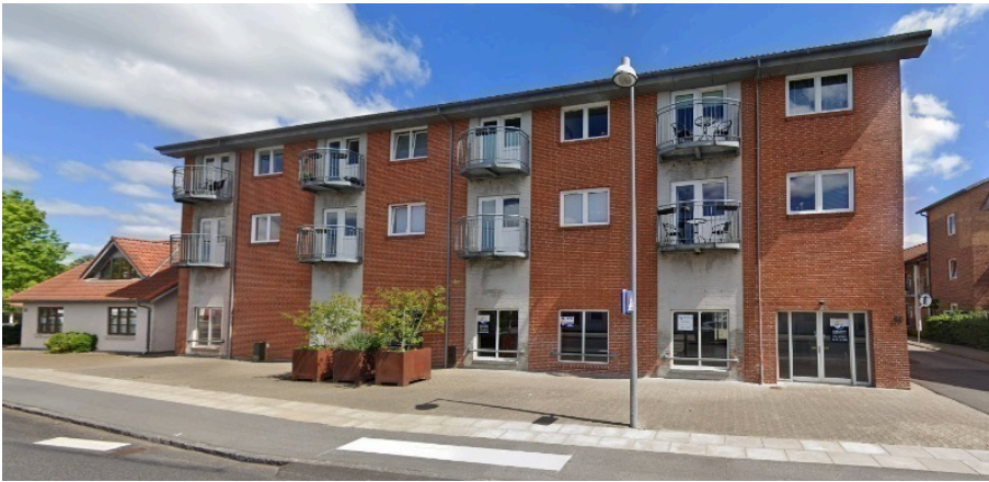
Etageejendommen Sunde Hovedgade 58-60 set fra syd mod nord.
