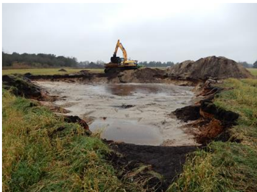
Udgravning af vandhul til løgfro og andre padder. Foto: Per Klit Christensen
