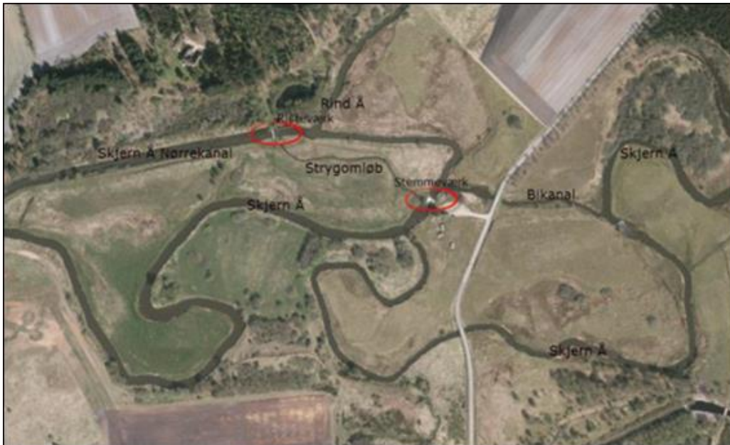
Figur 2. Oversigtfoto af forholdene omkring stemmeværket i Rind Å, ristebygværket ved indløbet til Nørrekanalen samt tilhørende vandforbindelser.
