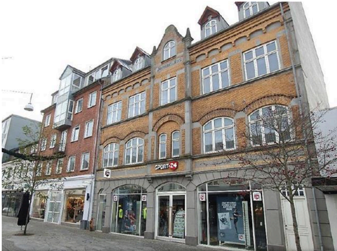
Foto af den bevaringsværdige facade mod Bredgade
