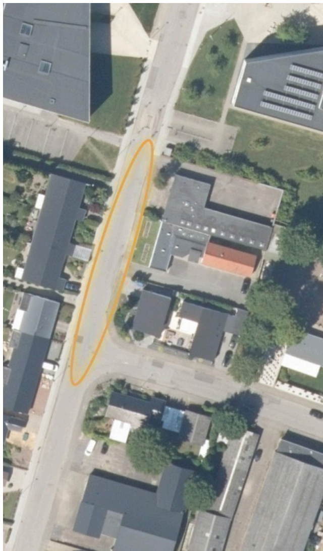
Billede af Tingvej ved busluse i Herning
