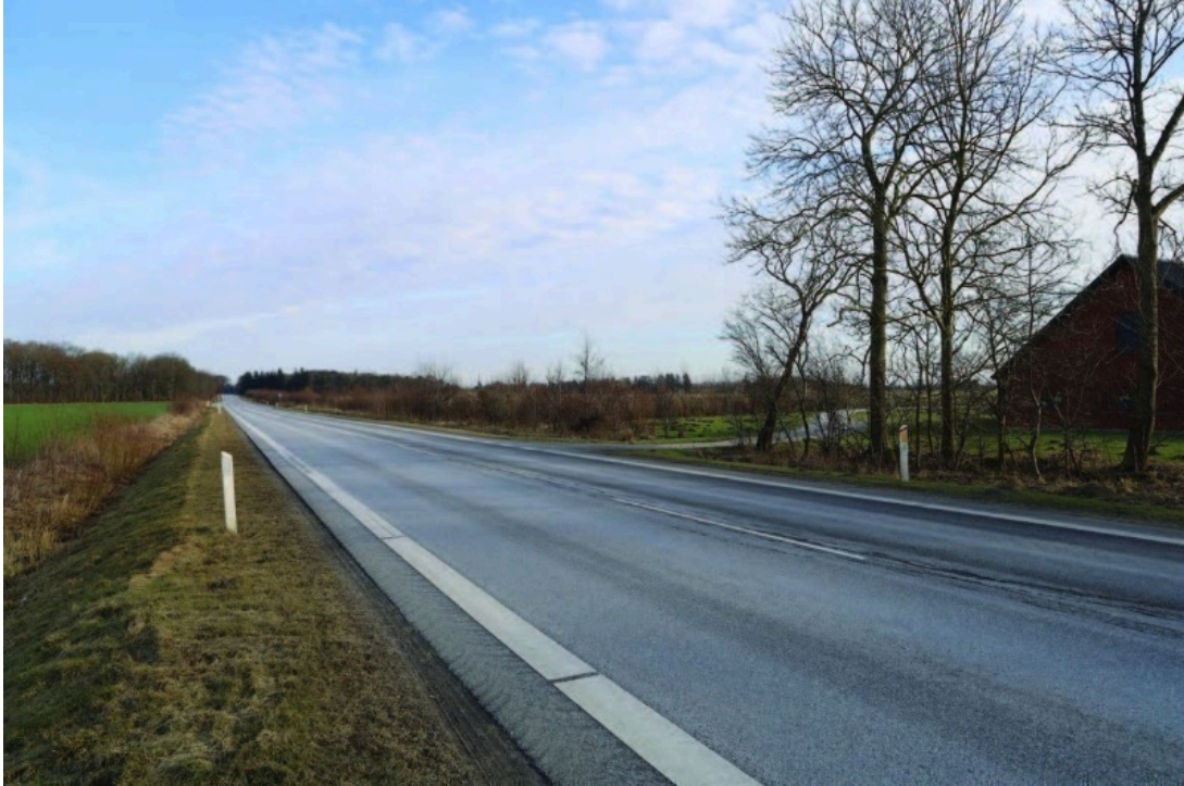
Vardevej i nordgående retning. Højspændingsstations placering er omtrentligt i midten af billedet. Foto: Energinet
