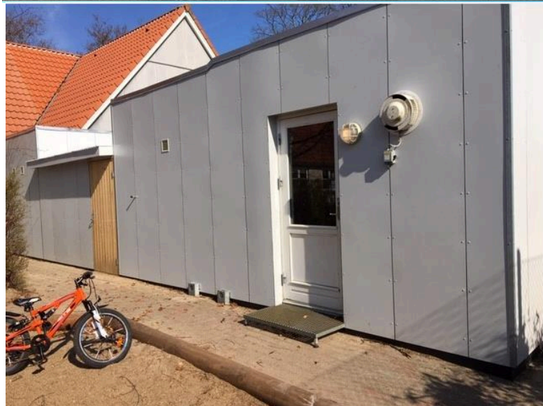
Indgangen før renovering.
