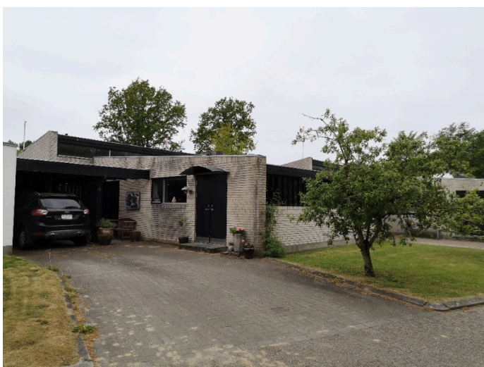
Foto af et rækkehus som fortsat fremstår i hvide kalkmursten og originale vinduesbånd.
