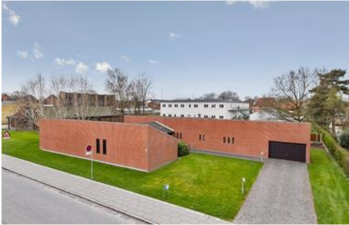
Facade mod Kaj Munks Vej (øst).
