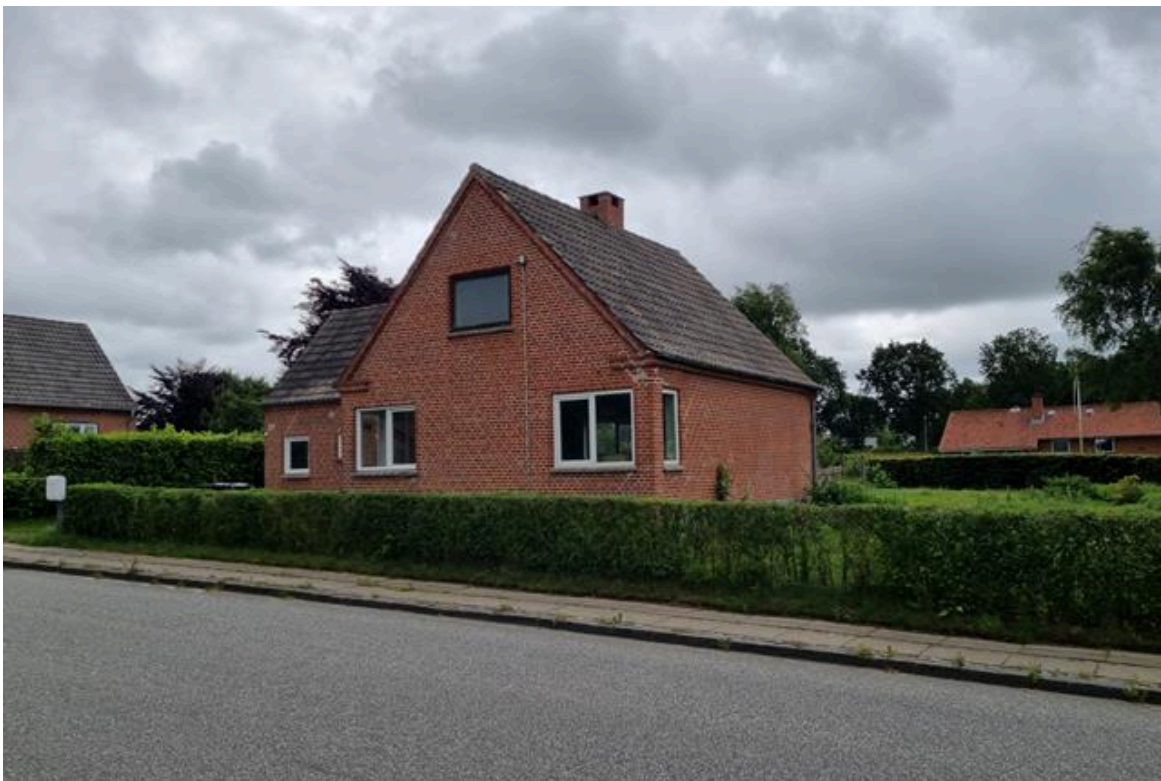
Langgade 17. Billedet er taget i august 2021.
