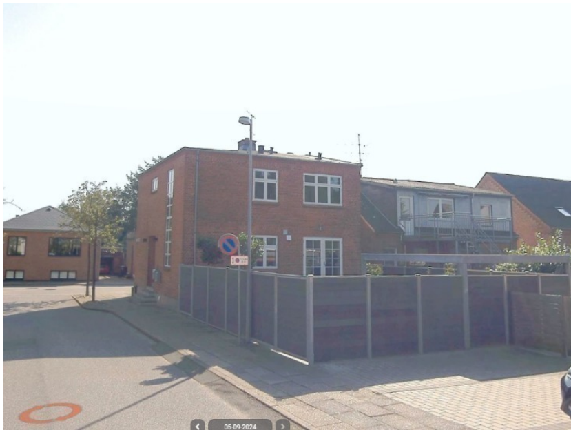
Fotos af ejendommen St. Blichersvænget 1 i Herning.
