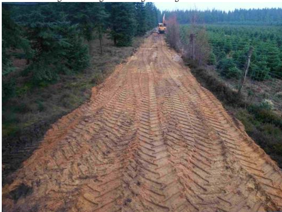
Billede 2. Rød / gul strækning efter færdigetablering
