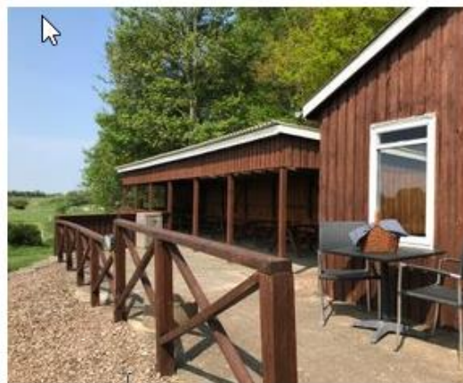
Overdækket terrasse inden anlæg af terrasser
