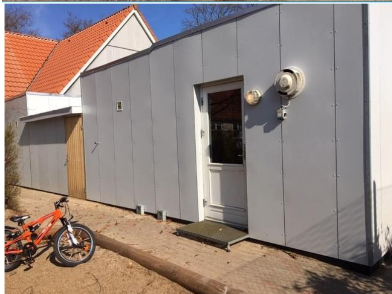
Indgangen før renovering.
