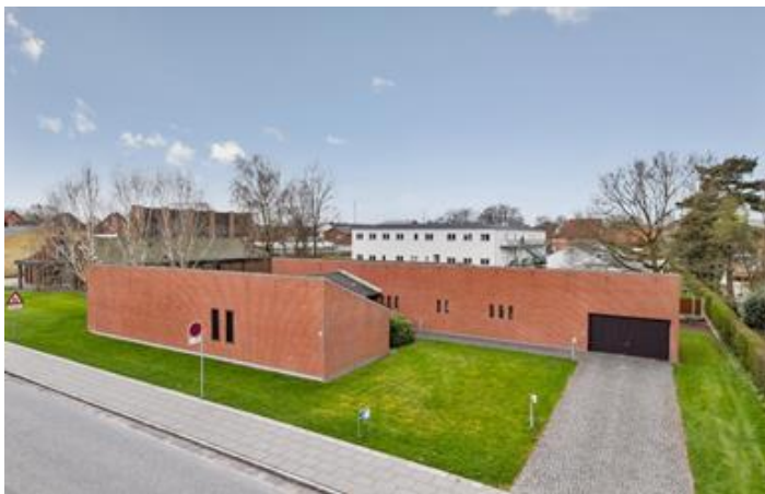
Facade mod Kaj Munks Vej (øst).
